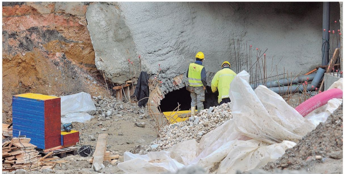
Trabajos de reconstrucción de la bóveda del Clamores.
