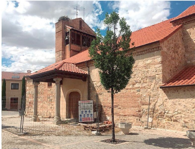
La iglesia continúa con las obras de reconstrucción.
