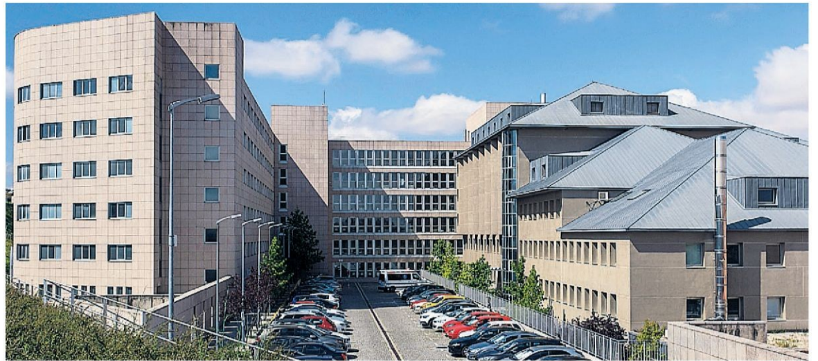
Vista general del edificio de hospitalización del Hospital General de Segovia.
