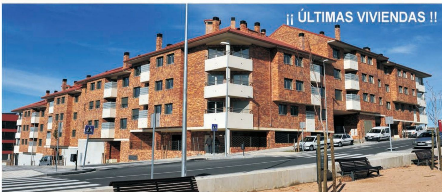
"MANZANA GOLDEN", Edificio de viviendas, locales, garajes y trasteros.
