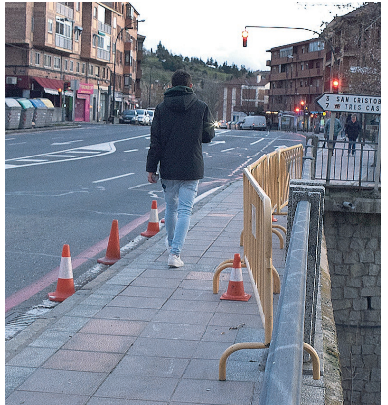
Unas vallas protegen la barandilla afectada por la caída del árbol.
