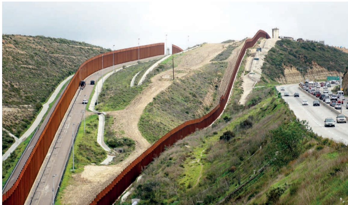
Muro que separa San Diego (Estados Unidos) de Tijuana (México) visto desde la parte norteamericana.
