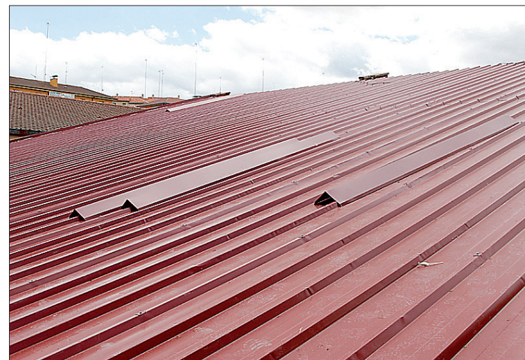
Cambio de cubiertas en una nave del IES Francisco Giner de los Ríos. / N. LL.
