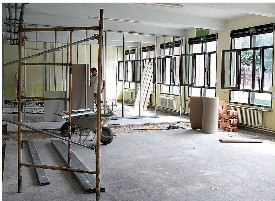
Construcción de cocina y comedor en el colegio San José. / NEREA LLORENTE
