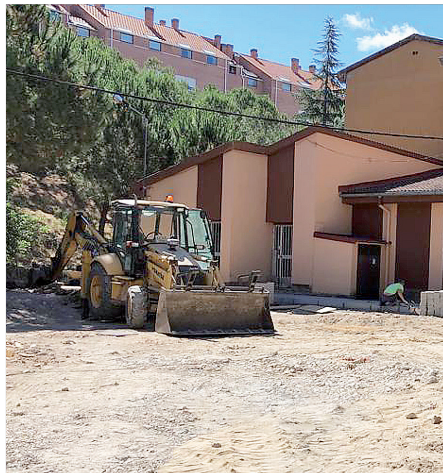
Trabajos de pavimentación y eliminación de barreras arquitectónicas desarrollados en los accesos
