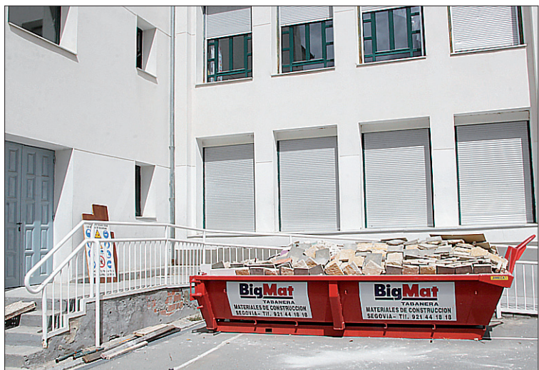
Contenedor de obra en el patio del CEIP Villalpando. // NEREA LLORENTE
