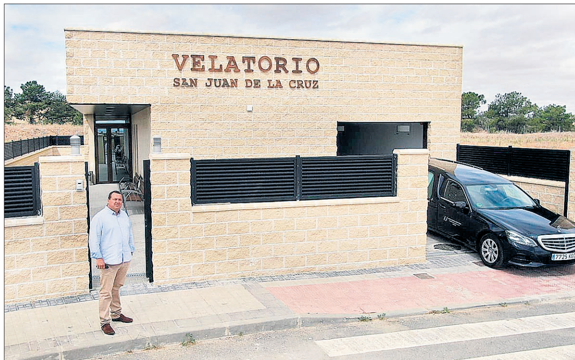
Fachada del Velatorio de Villacastín, ante la cual posa el director de la Agencia Santa Teresa, Óscar de la Fuente. / E.A.
