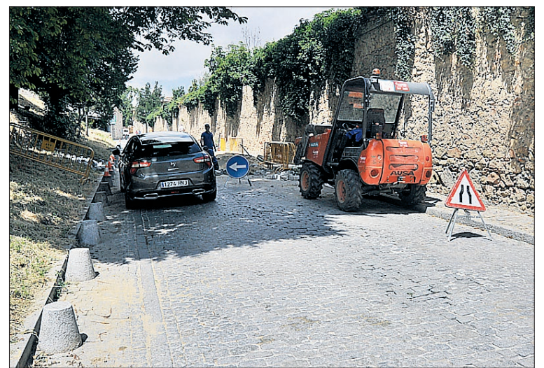
Imagen de unas obras previas en la calle Doctor Velasco. / KAMARERO
