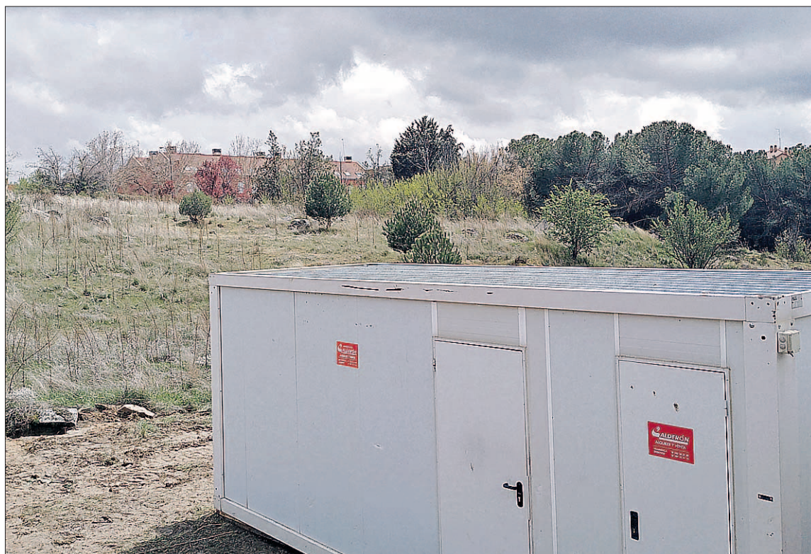
Caseta de obra instalada en el terreno donde se construirá el centro, entre la calle El Terminillo y la avenida de Vía Roma. / G. A.
