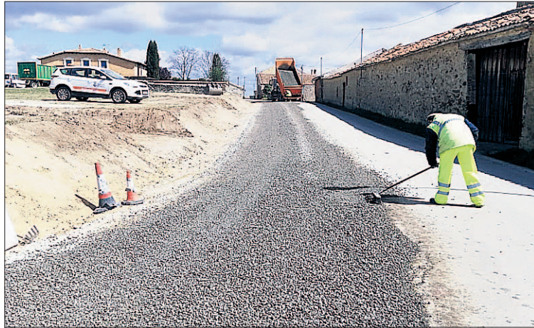
La institución provincial ha destinado unos 13.500 euros a los trabajos. / E. A.
