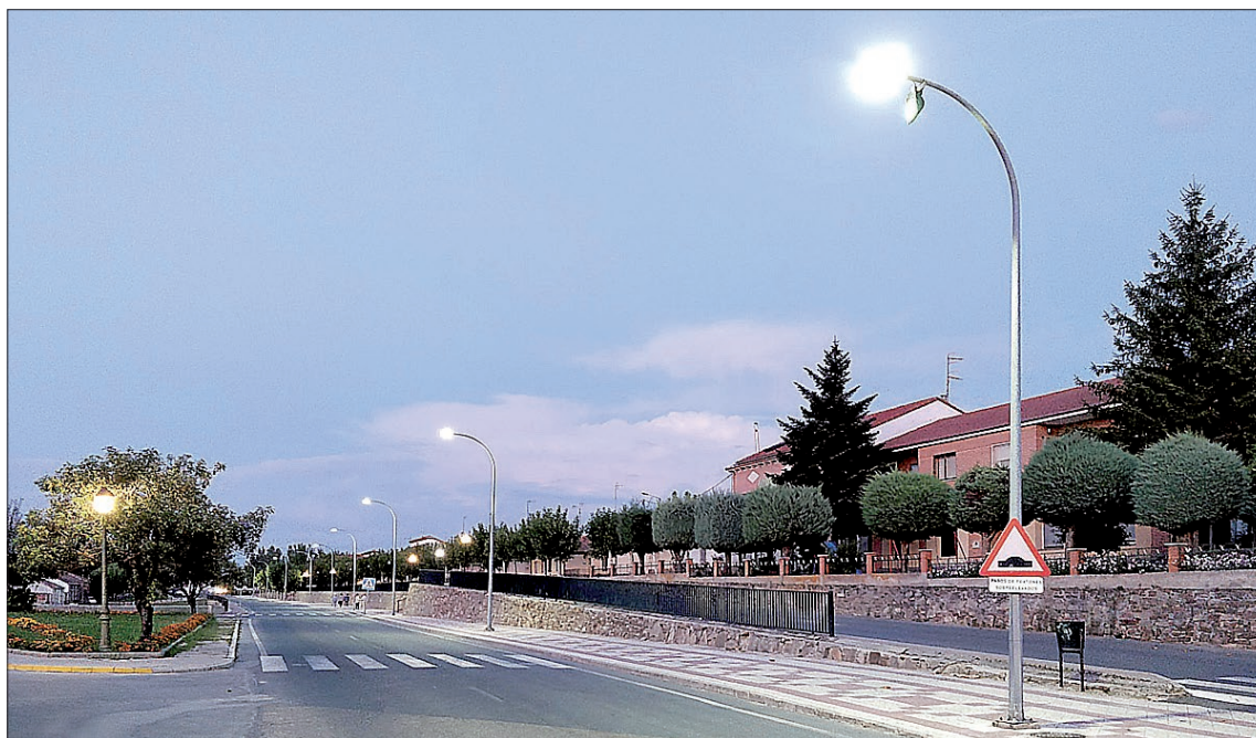
Algunas de las luminarias LED ya están instaladas en la avenida de entrada a la localidad de Coca desde Santiuste. / D. RUBIO
