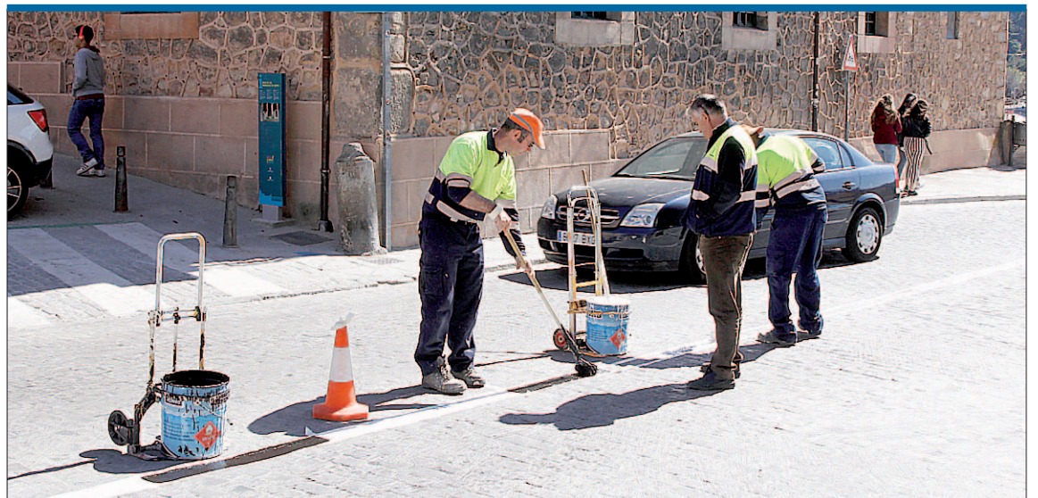
El fin de una gran obra. En la jornada de ayer se procedió a la colocación de la señalización horizontal —línea que delimita los dos carriles, uno de subida y otro de bajada— de la calle San Juan como colofón a las obras que se llevaron a cabo desde junio de 2018 hasta enero de este año. / FOTO: NEREA LLORENTE
