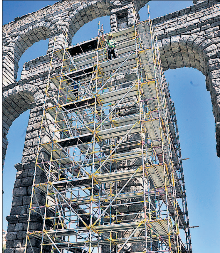
El andamio no será necesario para colocar la réplica de la Virgen. / KAMARERO
