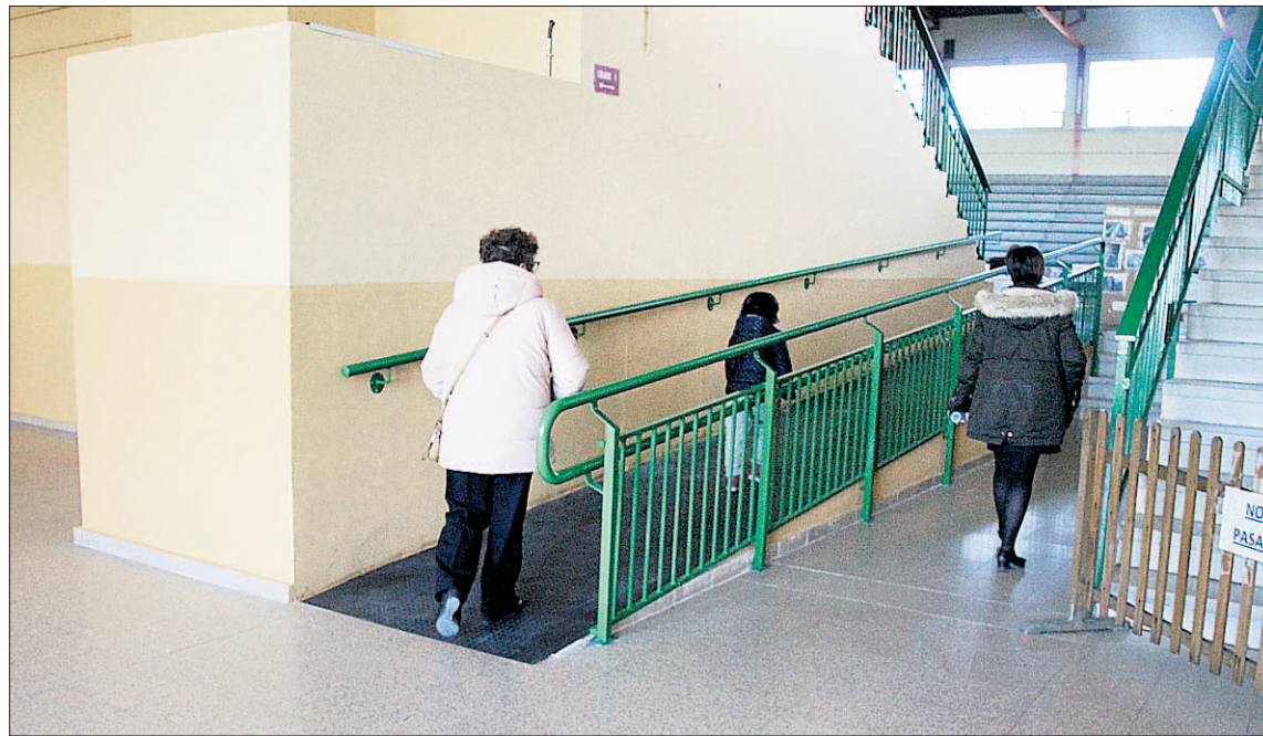
Nueva rampa instalada en el acceso a las gradas del pabellón Santa Clara, con renovación de aseos incluida. / C. NÚÑEZ
