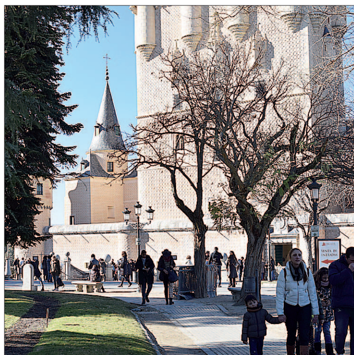
El Alcázar seguirá abierto a la visitas, a pesar de las obras. / ROCÍO PARDOS
