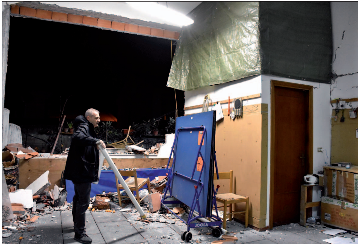
Un hombre inspecciona los daños en el interior de un edificio tras el terremoto ocurrido ayer en Sicilia. / EFE
