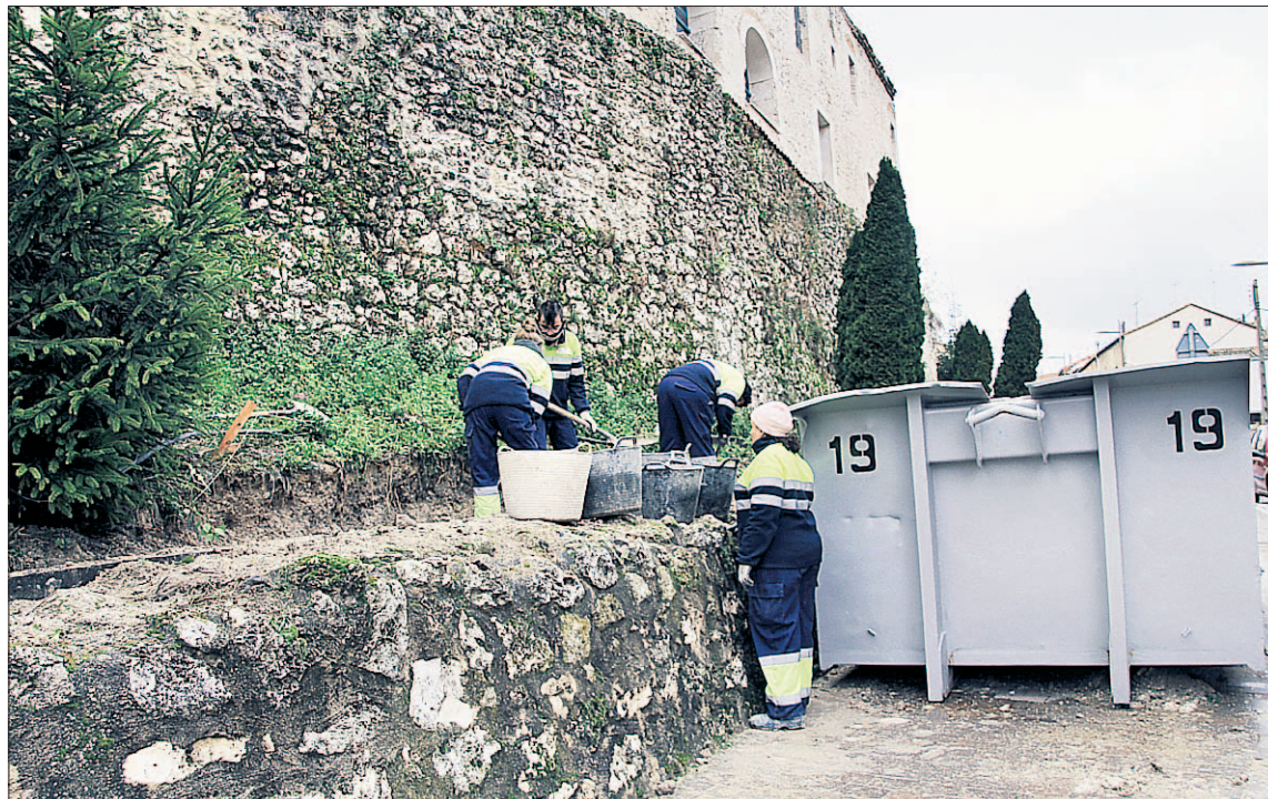
Trabajadores en el talud de Correos, realizando las labores de la parte práctica del programa formativo. / CHANTAL NUÑEZ
