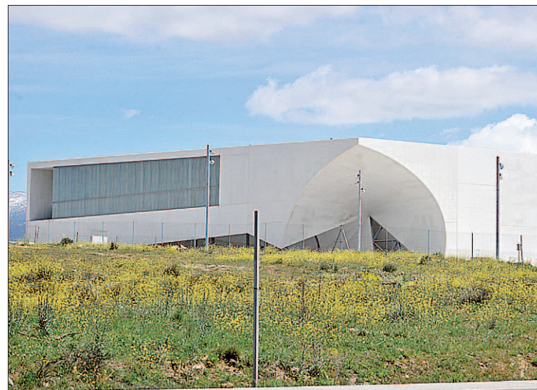
Estado actual de las obras de construcción del CAT. / KAMARERO
