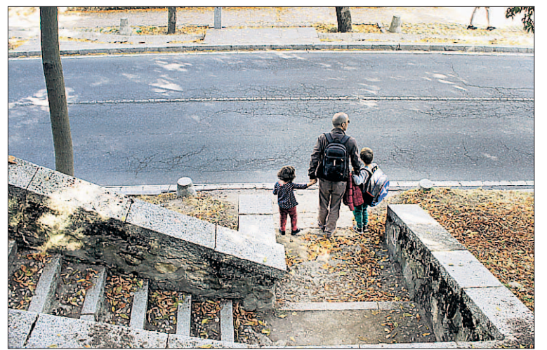
Escalera de acceso situada junto a la Muralla en la zona del Museo Zuloaga. / E. A.
