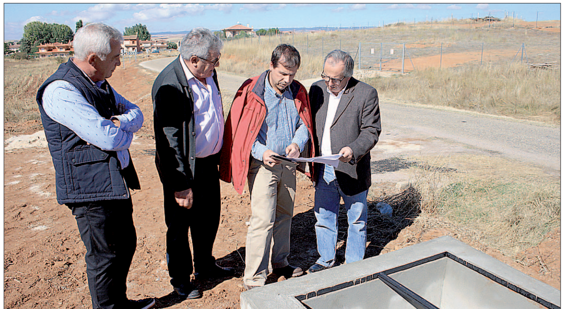
El delegado de la Junta visitó las obras, junto con el alcalde de Boceguillas. / EL ADELANTADO
