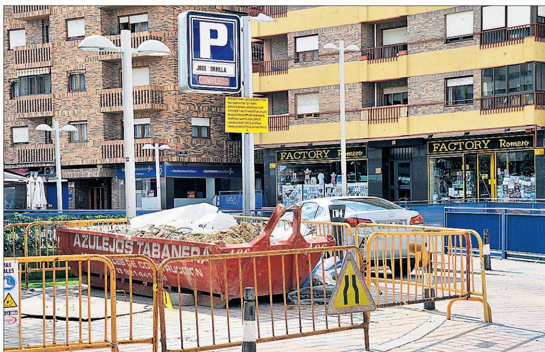
Los trabajos de mejora en el aparcamiento de José Zorrilla llevan varias semanas en marcha. / KAMARERO
