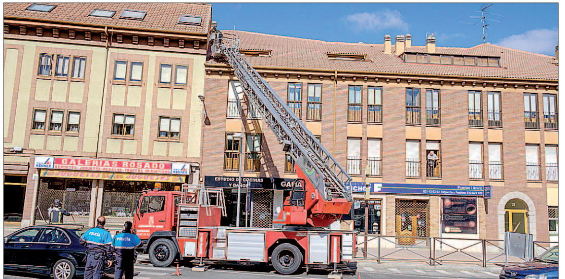
Los bomberos desplazaron un vehículo autoescala para acceder al lugar donde se registró el desprendimiento. / KAMARERO
