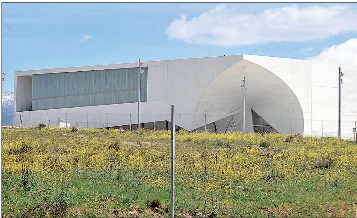
El edificio del CAT, aún pendiente de su conclusión, albergará el proyecto de innovación tecnológica. / NEREA LLORENTE
