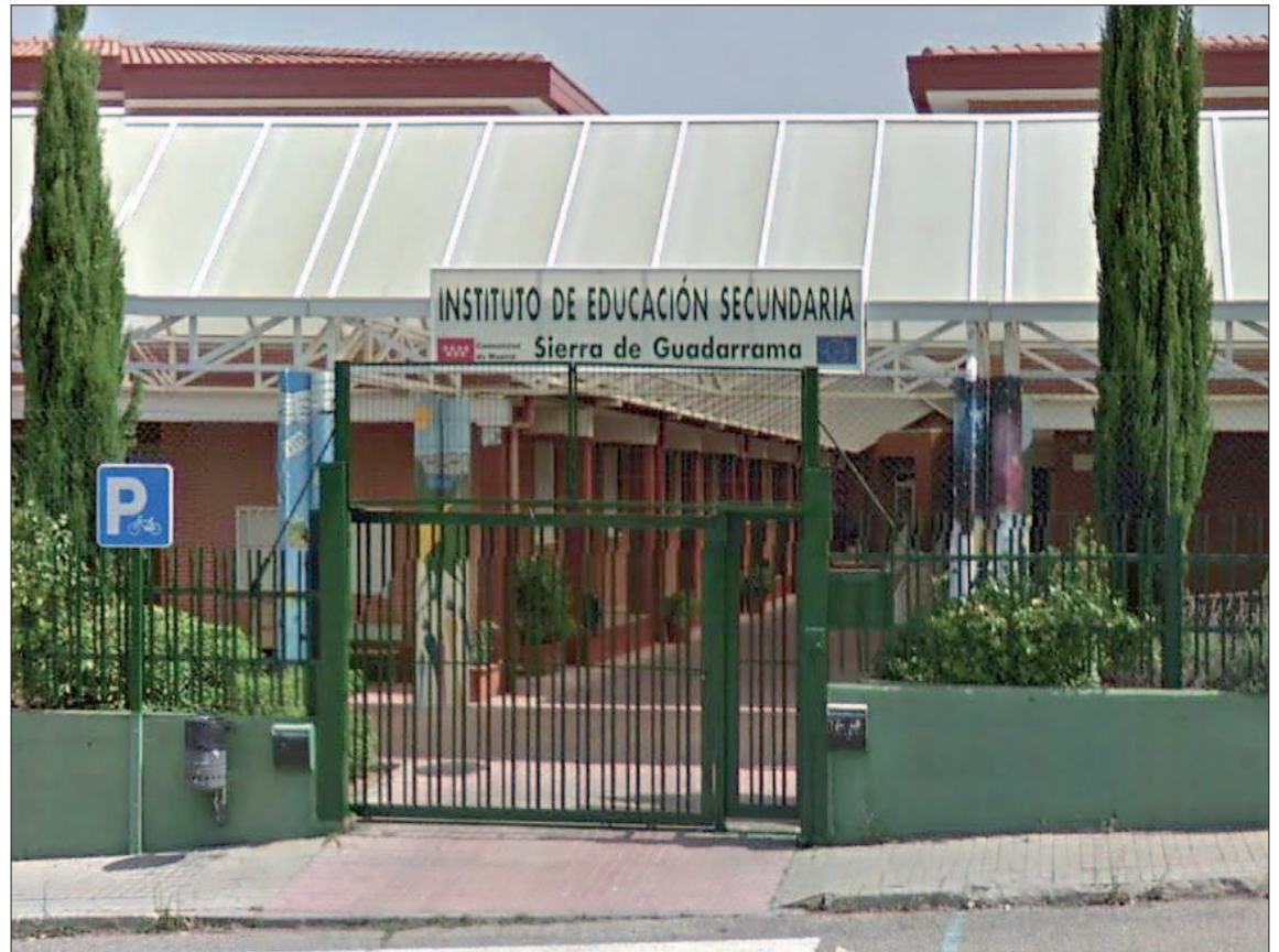
El director del instituto, junto con un trabajador, colocaron cámaras para, posiblemente, detectar vandalismo. / EUROPA PRESS
