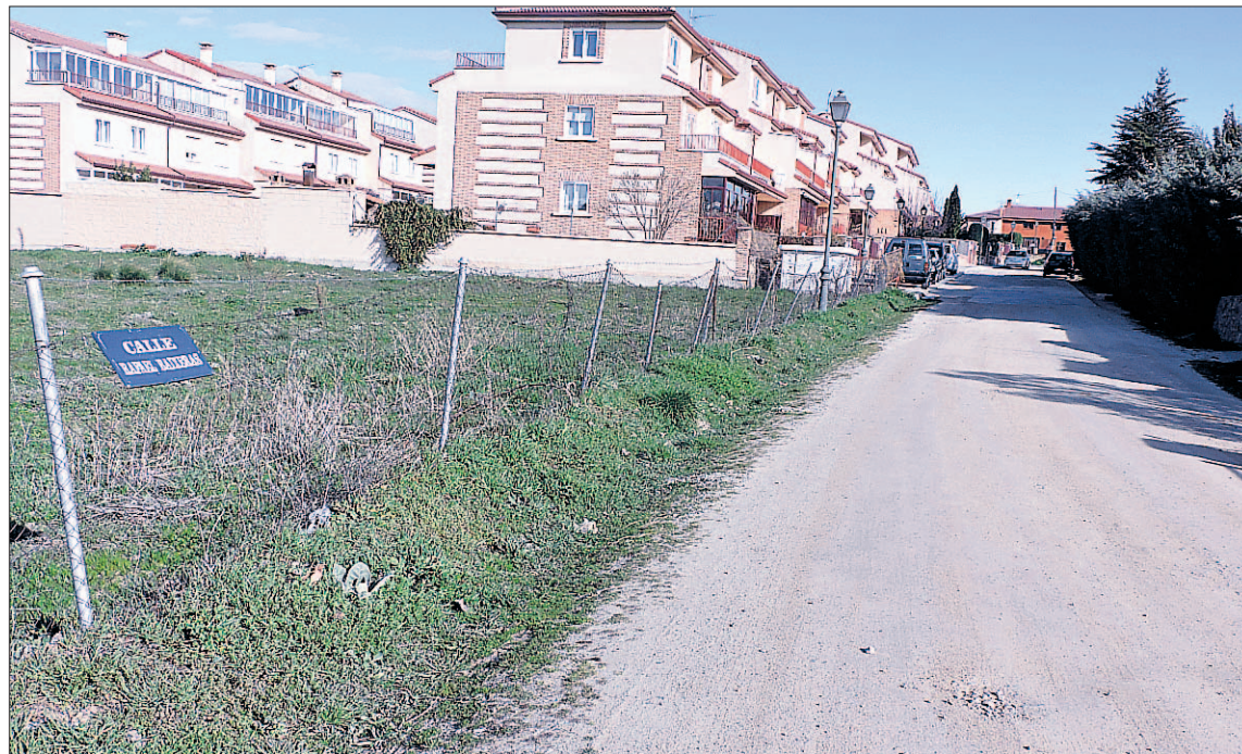
El Ayuntamiento continuará con las obras de asfaltado en todos los núcleos. / EL ADELANTADO
