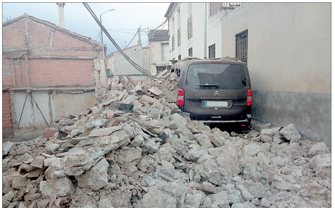
Imagen de muro caído sobre el vehículo, sin causar daño a sus ocupantes. / EL ADELANTADO
