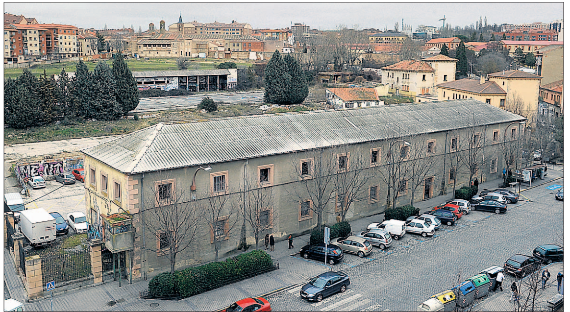
Zona sur del antiguo regimiento de artillería en la avenida de la Constitución, junto a la plaza de la Universidad. / KAMARERO
