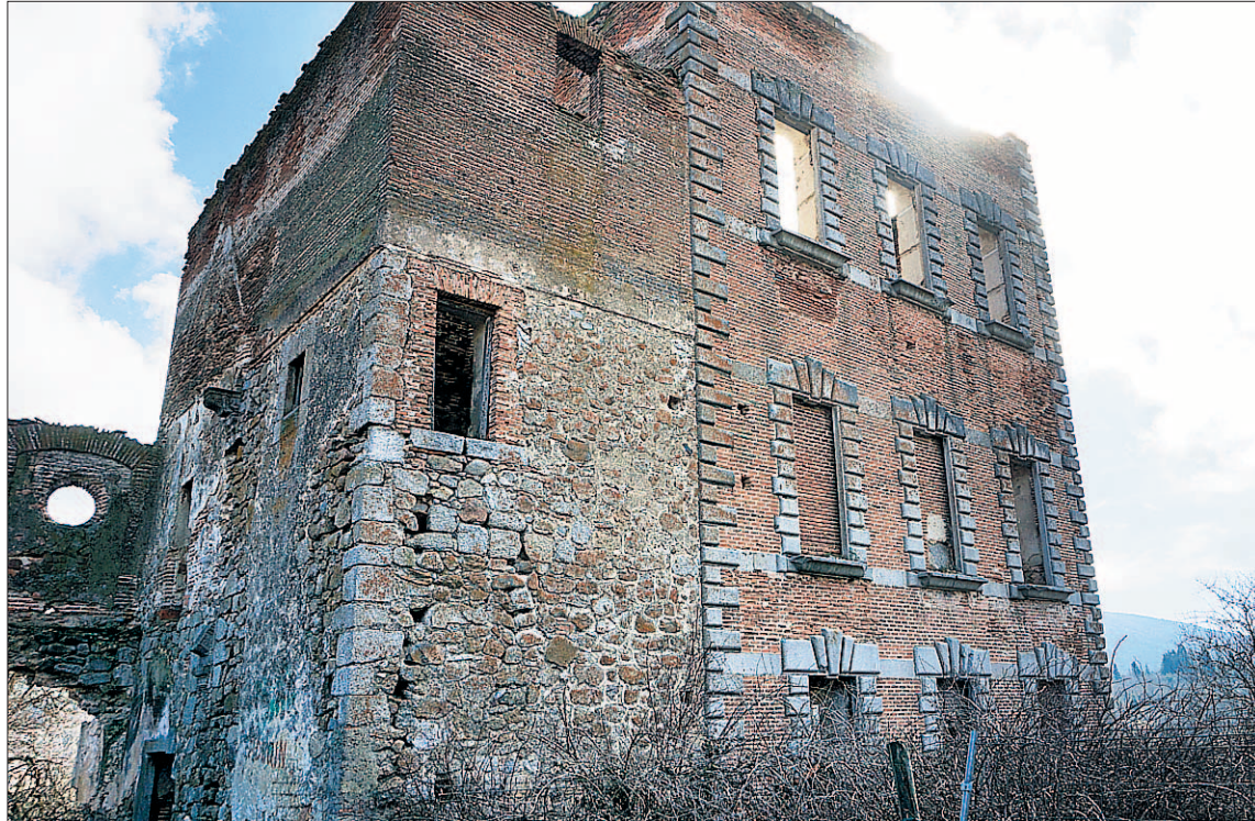
El Palacio de Valsaín, que se encuentra casi en ruinas y rodeado de basura, está a las afueras del municipio. / LORENA SANZ
