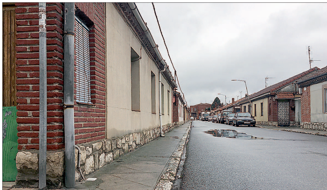
Inversiones gracias al superávit y la aportación de la Diputación permitirán actuar en estas aceras./ C.N.
