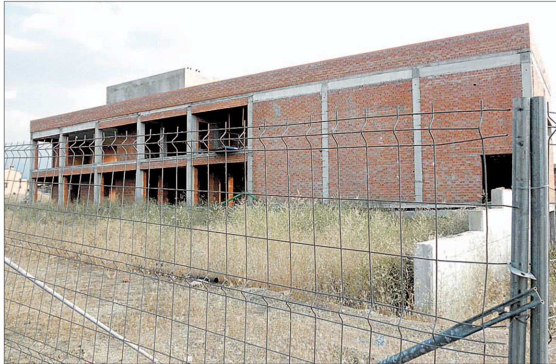
Imagen de archivo del futuro centro, en construcción desde hace unos diez años. / EL ADELANTADO
