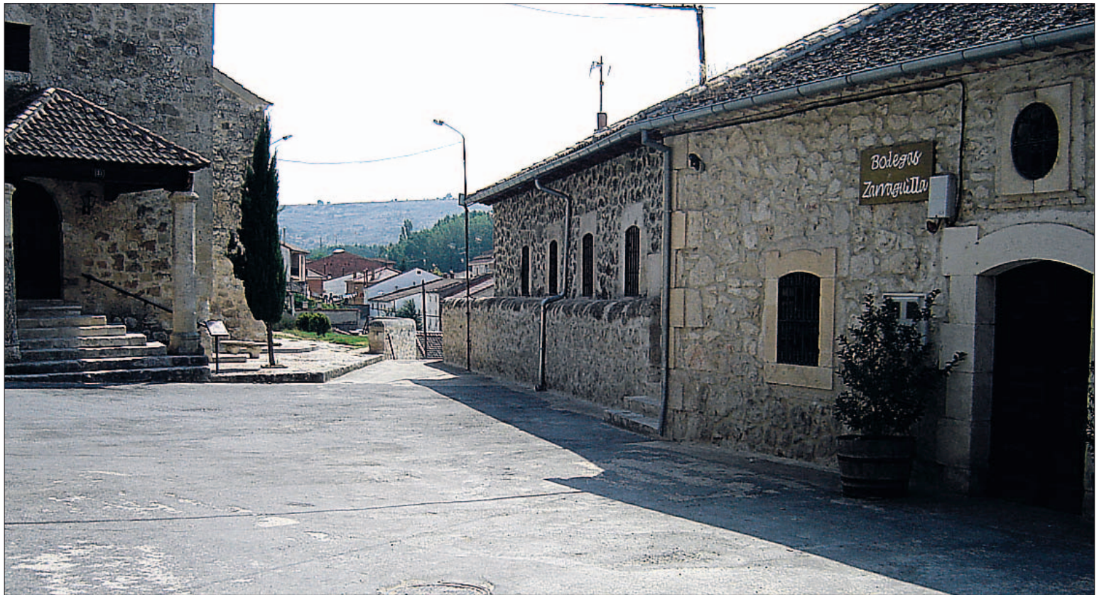
Fachada de Bodegas Zarraguilla.
