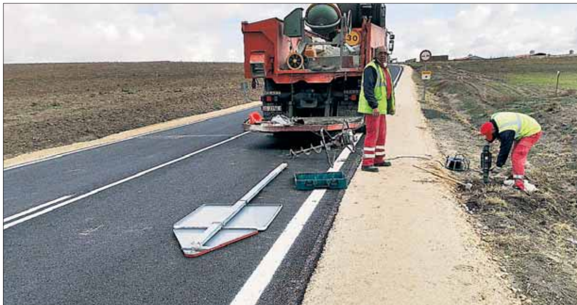
El plazo de ejecución de las obras ha sido de dos meses. / EL ADELANTADO
