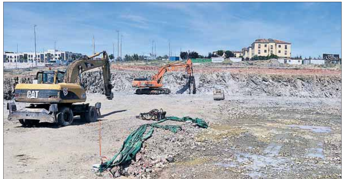
Estado actual de las obras de construcción del edificio de juzgados. / KAMARERO
