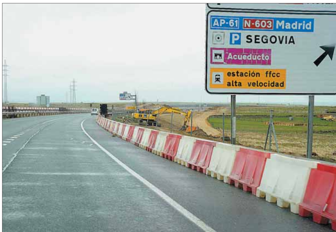
Obras del desdoblamiento de la variante de SG-20 que ejecuta el Ministerio de Fomento. / KAMARERO
