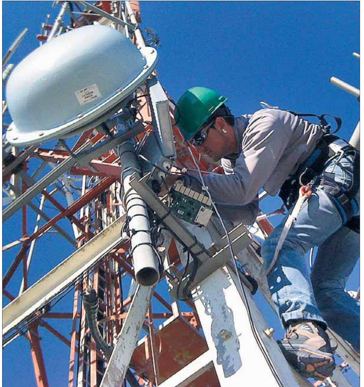
Un operario trabajando en una antena de telefonía móvil. / EUROPA PRESS
