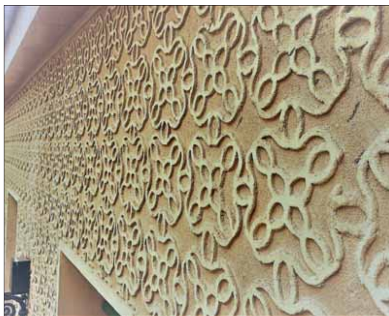
Fachada extramuros. / E MAGANTO
