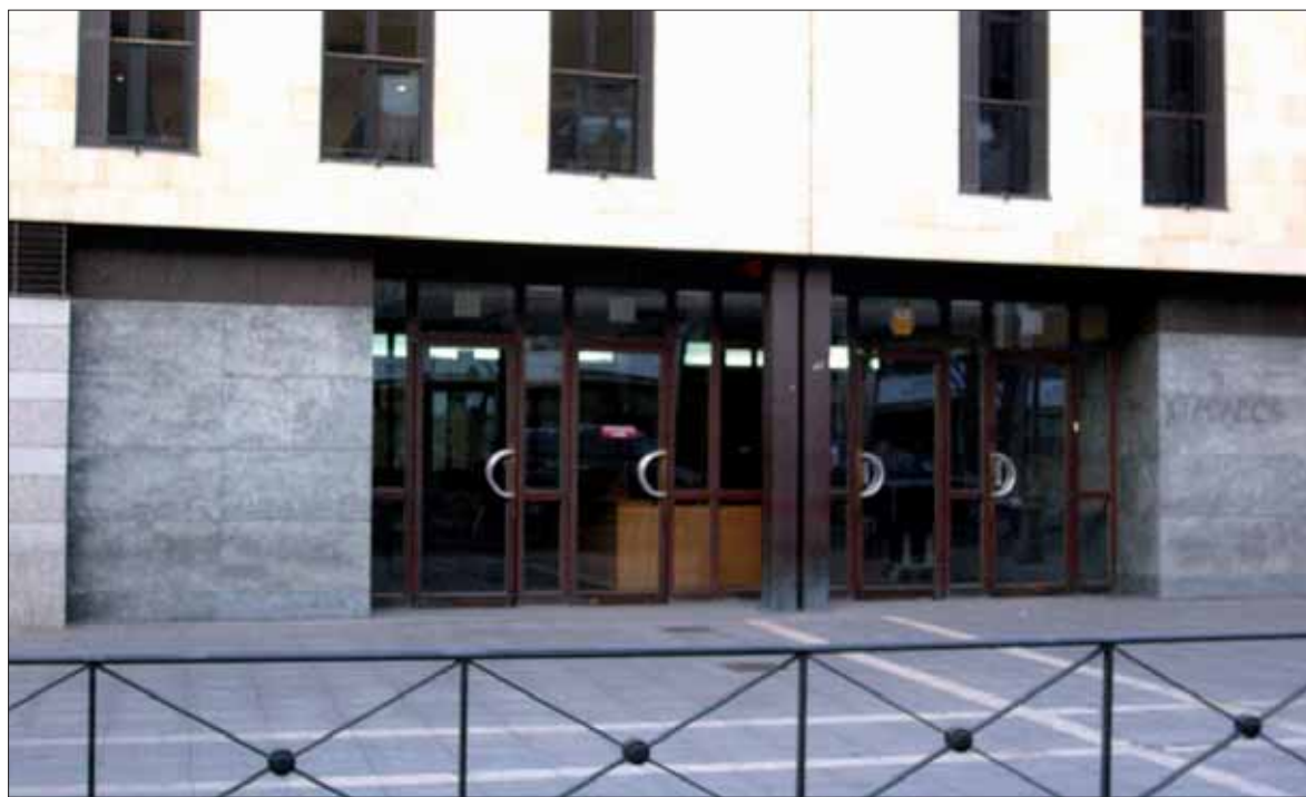
Entrada al edificio de los Juzgados de Valladolid. / EUROPA PRESS
