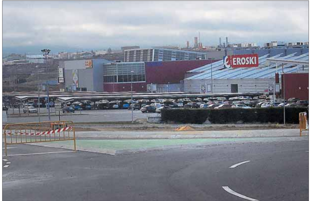
El entorno del Centro Comercial Luz de Castilla ha llevado a cabo últimamente algunas obras en los accesos. / EL ADELANTADO
