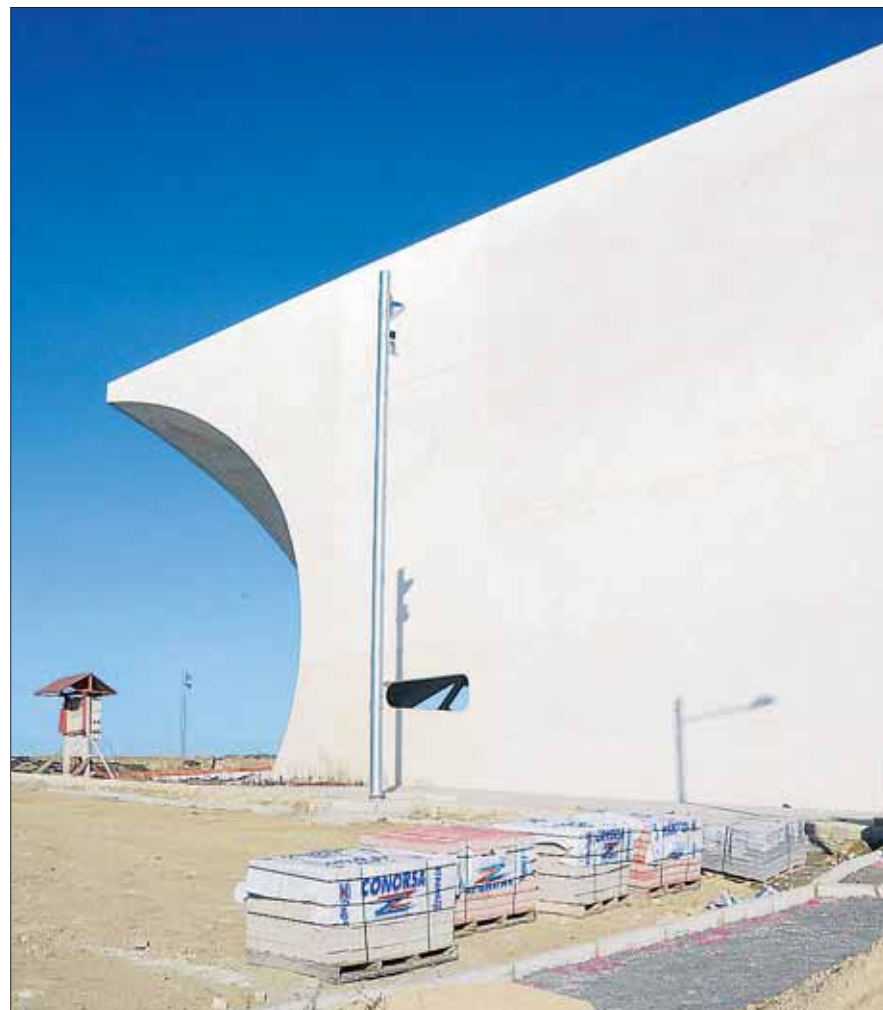
Inicialmente estaba previsto que las obras de este edificio del CAT, denominado CIDE, concluyera
