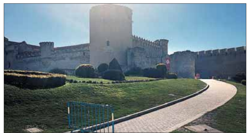
La rampa de acceso al Castillo se abrirá a los peatones en estos días. / C.N.
