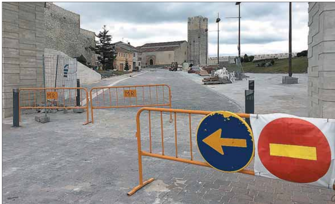
El cierre al tráfico rodado de los accesos al recinto amurallado permitirá trabajar sobre la calle La Pelota./ C.N.
