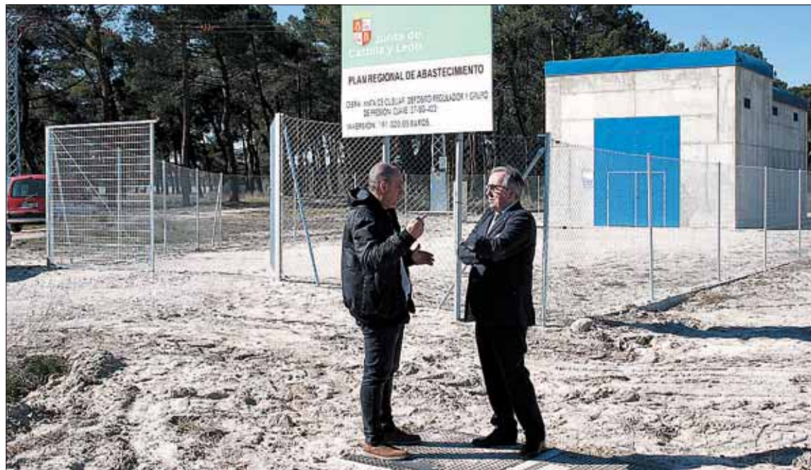
El teniente alcalde y el delegado de la Junta, junto al nuevo depósito que pasa de 50 a 200 metros cúbicos de capacidad. / E.A.
