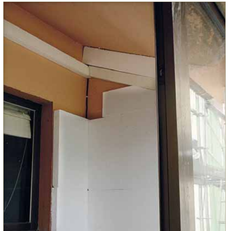
Aislamiento térmico de fachadas por el exterior. / J.A. SANTOS
