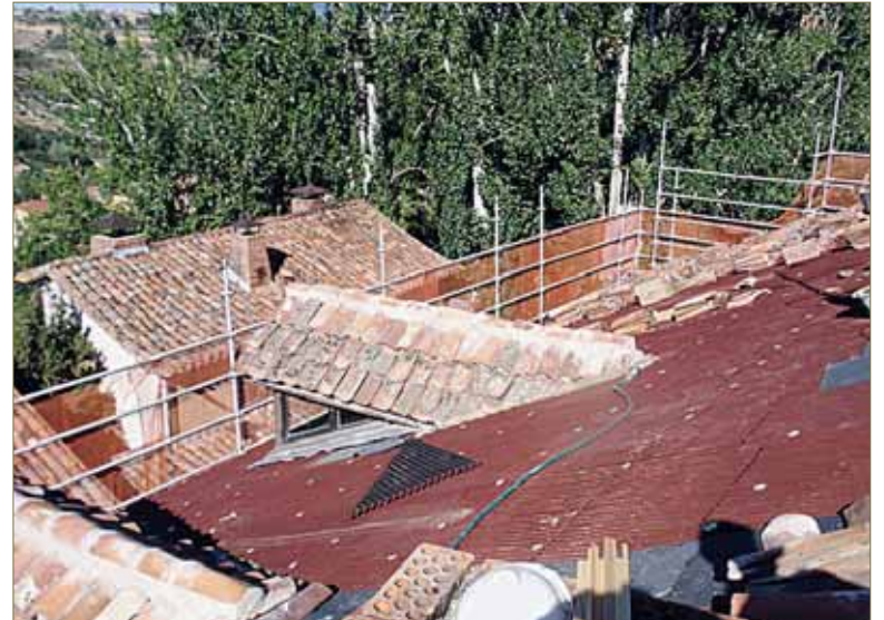
Trabajos de cobertura sobre impermeabilización. / J.A. SANTOS
