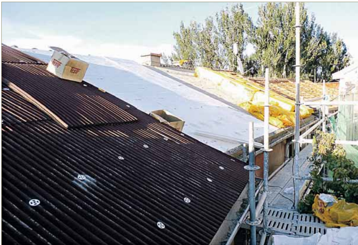
Aislamiento e impermeabilización de cubierta. / J.A. SANTOS
