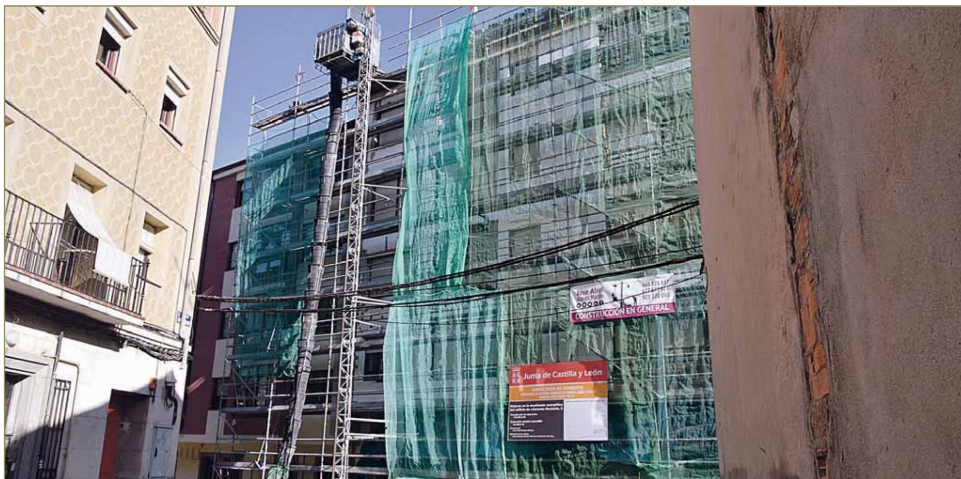
La instalación de las válvulas para el control de costes de calefacción fomentando el ahorro en este edificio de la calle Machado han sido realizadas por el Grupo Monedero. / J.A. SANTOS
