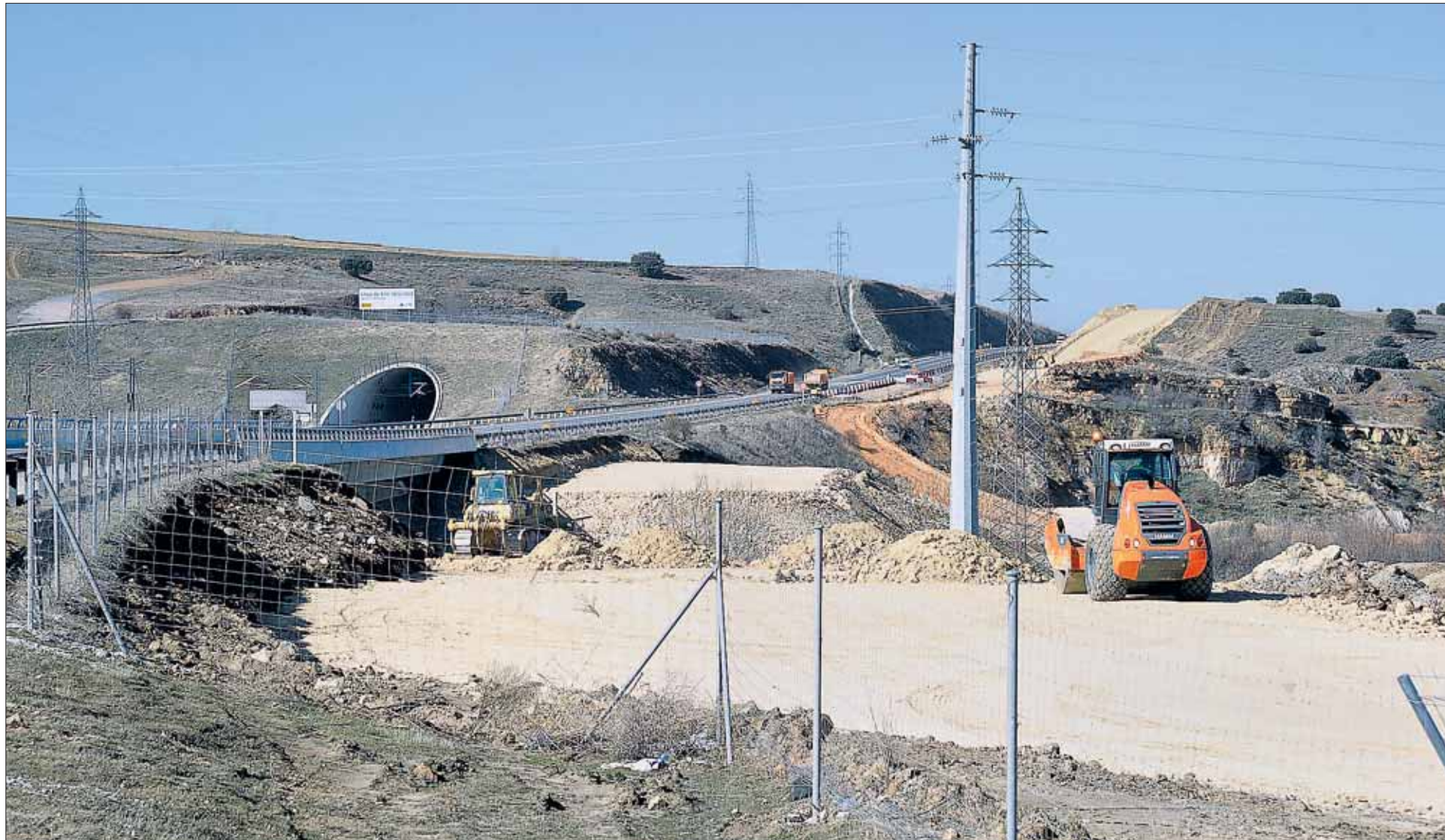
La maquinaria pesada sigue trabajando en el desdoblamiento de la vía con el movimiento de tierras previo a la construcción de la calzada. / KAMARERO
