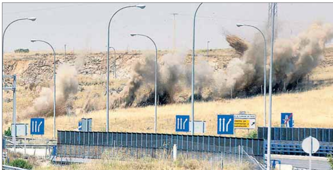
En agosto de 2016 tuvieron lugar ya algunas voladuras de excavación de terrenos en la obra. / JUAN MARTÍN
