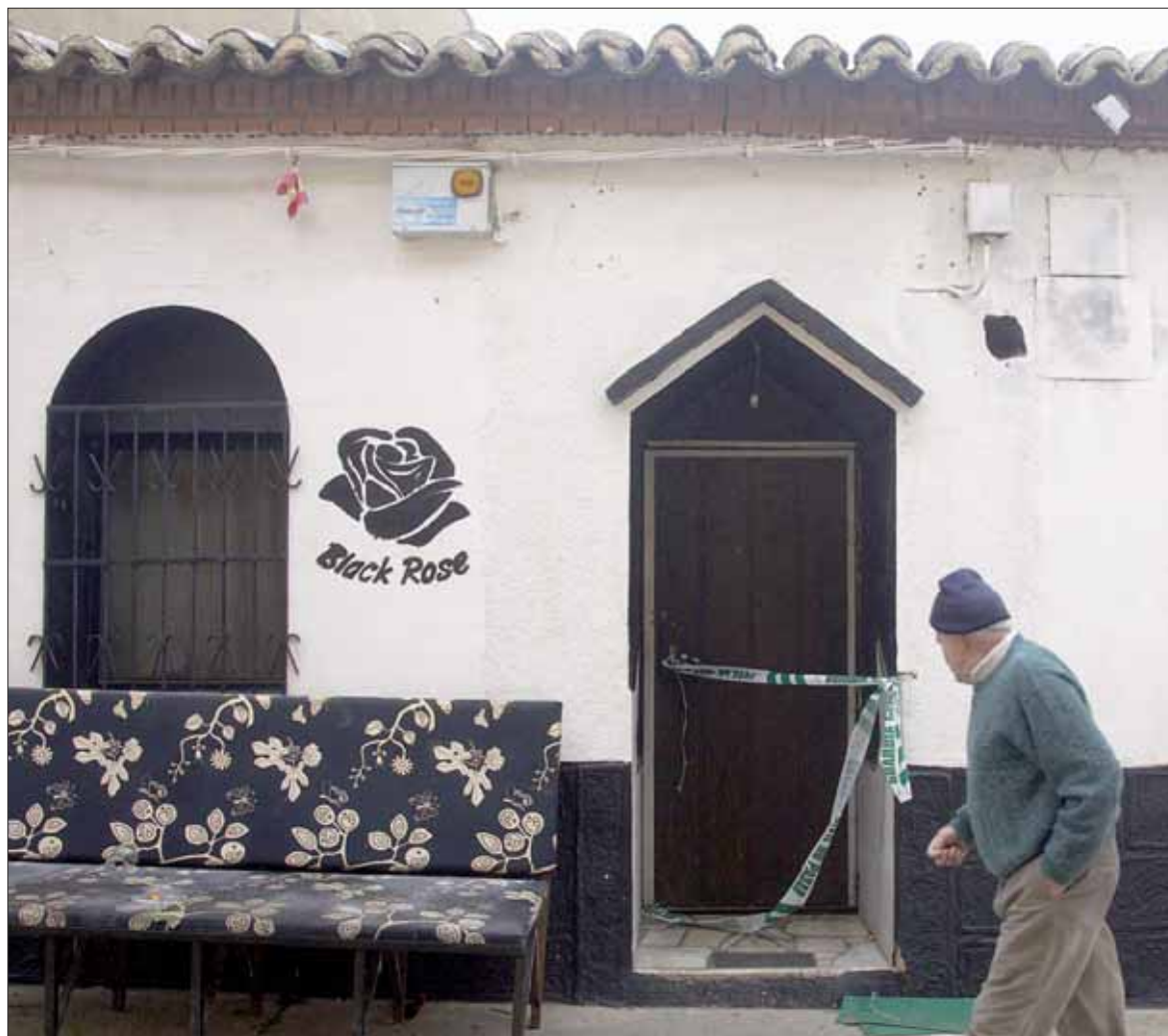
La imagen muestra la fachada del bar de Villafáfila (Zamora) donde ocurrió el hundimiento del suelo. / EFE
