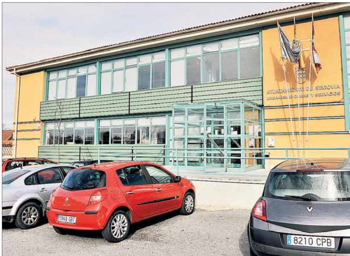
Sede del Servicio de Urbanismo perteneciente al Ayuntamiento de Segovia. / KAMARERO
