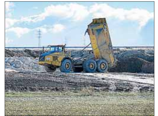
Movimiento de tierras en uno de los tramos. / K.
