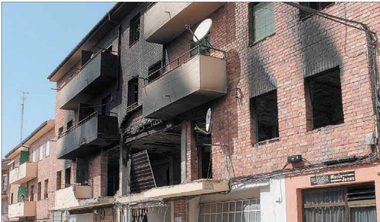
La deflagración causó importantes daños en la fachada que no afectan a la estructura del edificio, según las primeras estimaciones técnicas./M.G.
