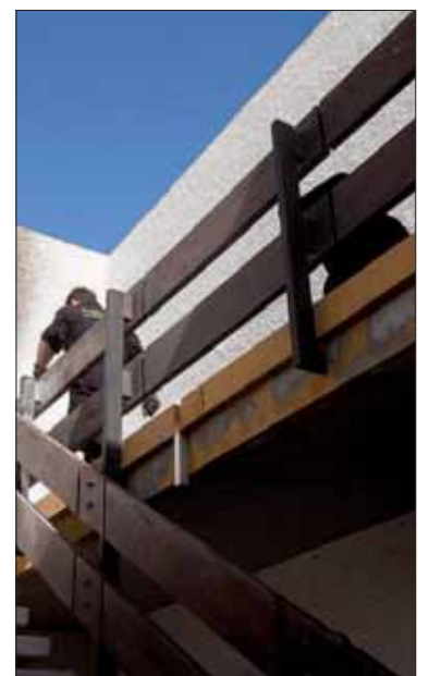
Domicilio que resultó afectado. / EFE
