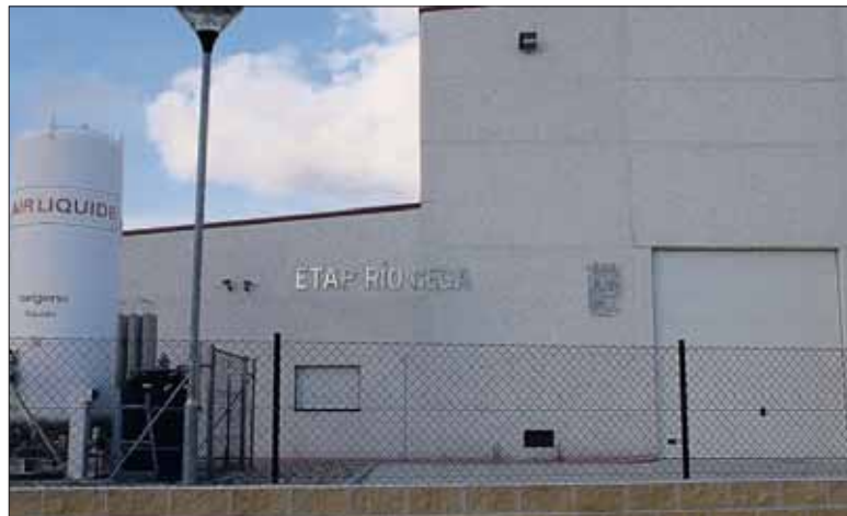
Instalaciones de la nueva estación de depuración de agua para el consumo. / JUAN CARLOS LLORENTE
