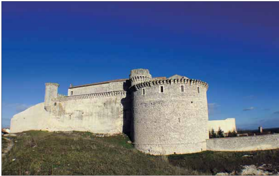
Fachada oeste del castillo con el adarve desmontado. / JUAN CARLOS LLORENTE
