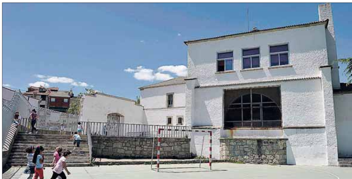
Fachada del colegio Arcipreste de Hita de El Espinar, que será reformado. / PEDRO L. MERINO
