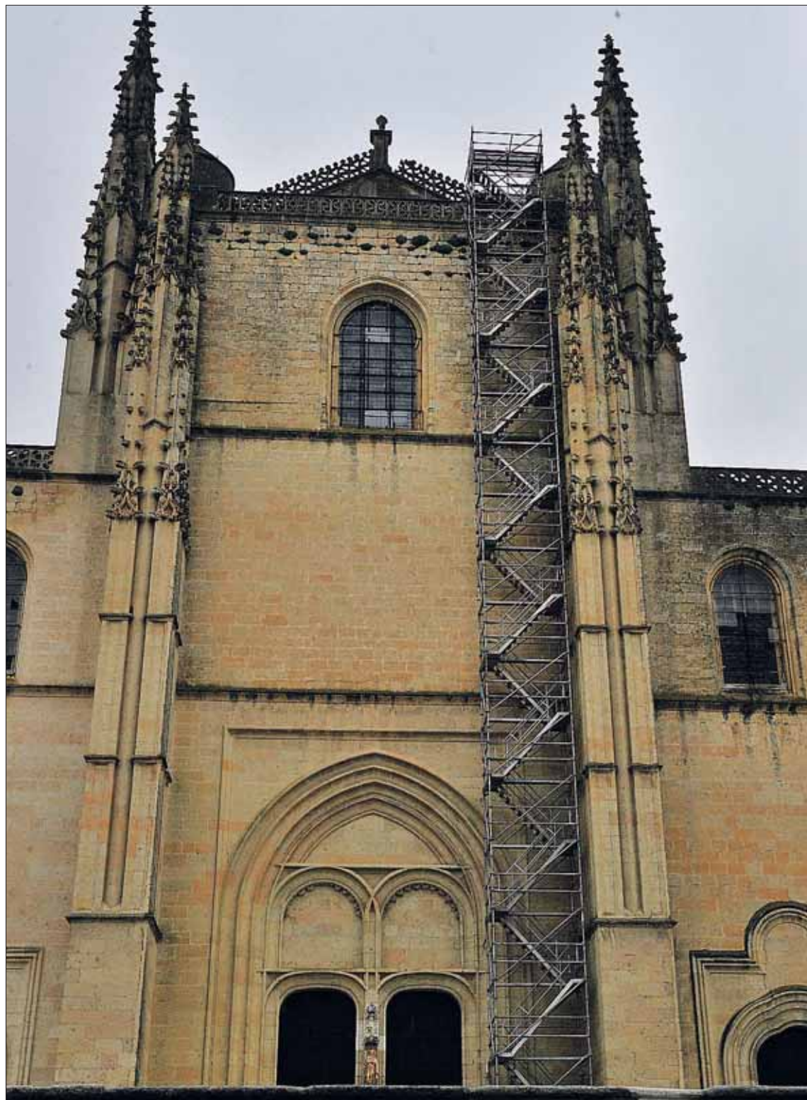
La Puerta del Perdón o de Santa María, junto al enlosado, tiene desde hace unos días este andamiaje. / KAMARERO
