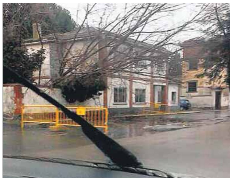
Un árbol, derribado por el viento en el patio de una vivienda en Coca. / E. A.
